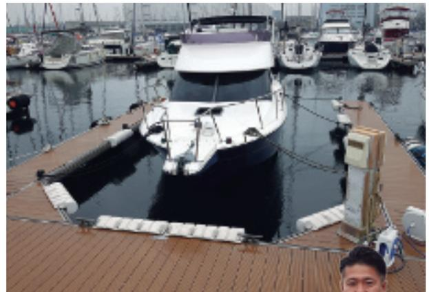
上：樹脂製だが、耐候性・耐久性の高いドッグフェンダーを用いることで、発泡スチロールのフェンダーに比べてマイクロプラスチックを削減することができる
