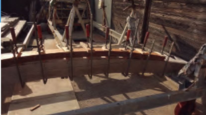
4、5枚の板を張り合わせ曲げて接着
